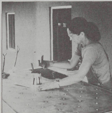
■ Het afwerken van de vlakke-plaatkollektor met schoolbordenverf.
