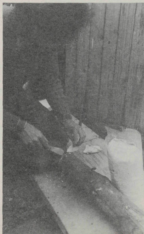
■ Broed wordt in de sleuven aangebracht
