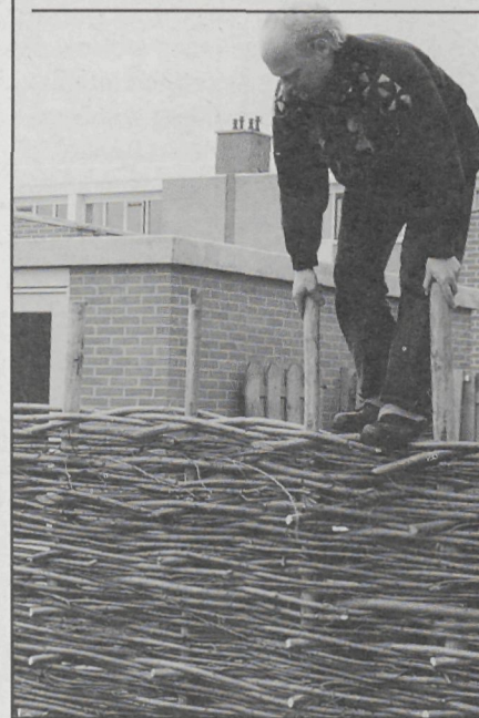
Eric Griek 'duwt' een nieuw gevlochten laag wilgentenen aan.
