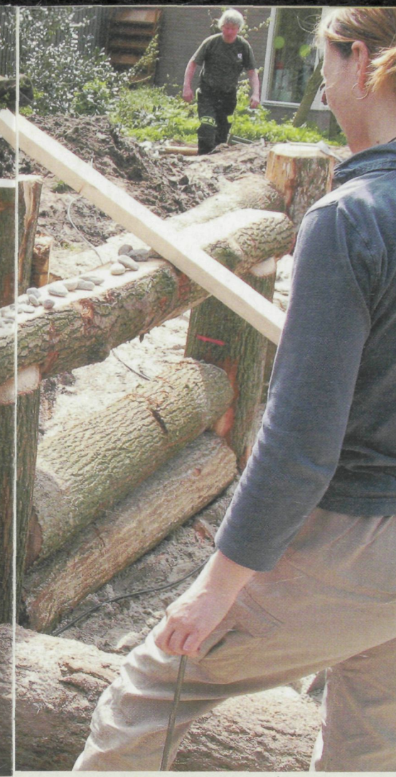
DE HUT HEEFT EEN BASIS VAN GESTAPELDE STAMMEN, DIE DEELS INGEZAAGD WORDEN VOOR DE STEVIGHEID.
