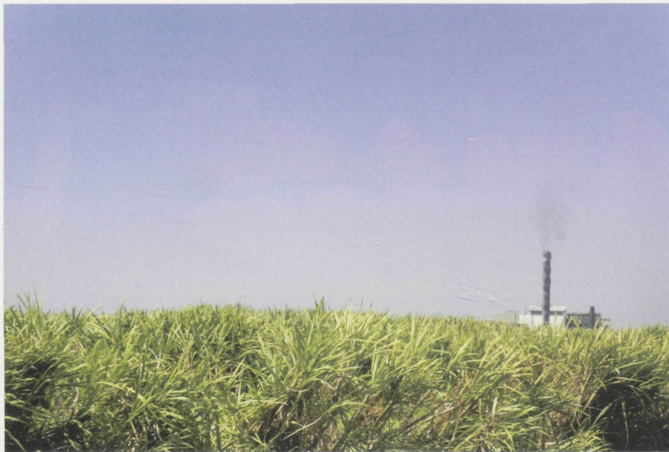
Ethanolfabriek in bedrijf
